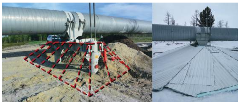
Рис. 6 Опора нефтепровода без навеса, и с навесом и системами мониторинга температуры и тепловых потоков
