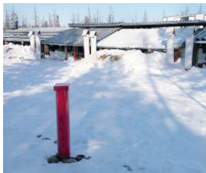
Рис. 8 Размещенные навесы, термометрические скважины и датчики теплового потока подземного нефтепровода
